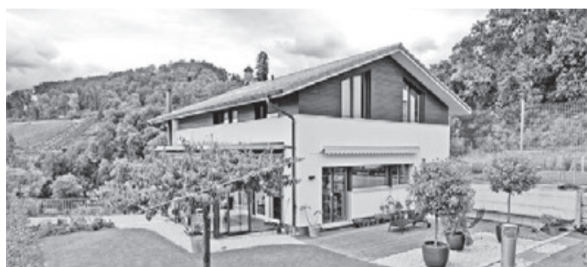
EFH: dreigeschossige Holzkonstruktion, Bj. 2007, Minergie-Zertifikat BL-129
