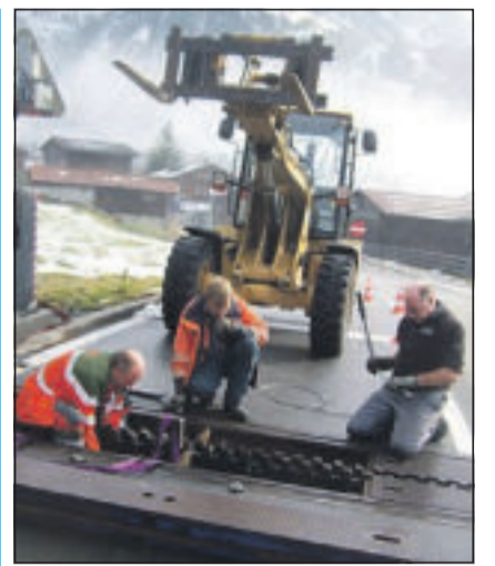
Ausbau der versenkbaren Zahnstange in Oberwald (Goms). Dies und viel mehr erfahren VVL-Mitglieder an diesem Samstagnachmittag im Dorfmuseum Bottmingen.
