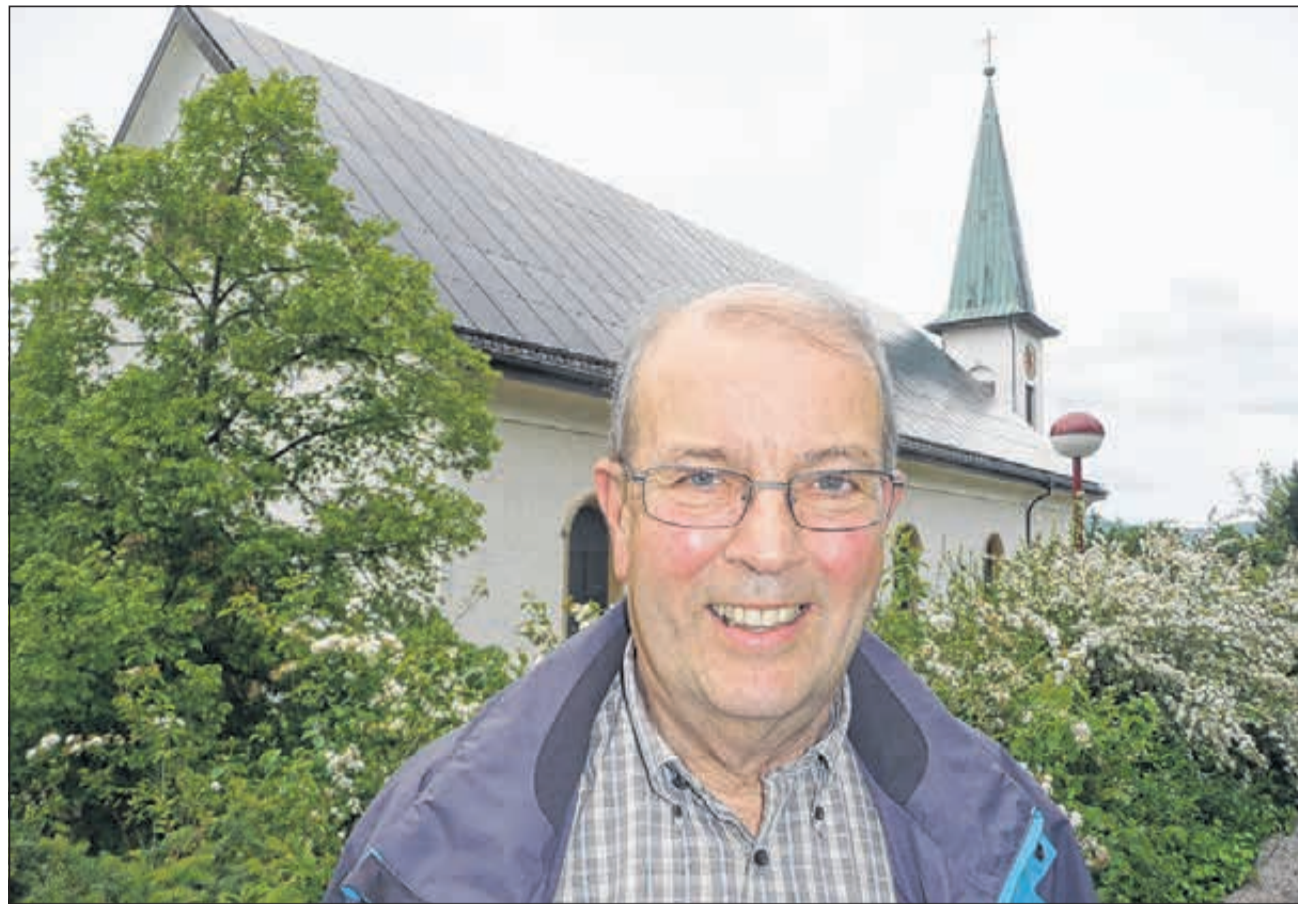
Solarpionier Hans Weber vor dem mit Solarzellen bestückten Dach der Römisch-katholischen Kirche Ettingen.
