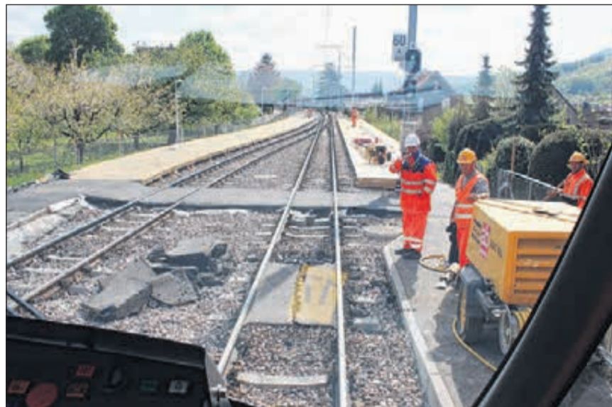
Auch während den Sommerferien ist «s'Bähnli» (BLT-Zehner) fast rund um die Uhr im Einsatz. Und ob garstig-herbstliches Regenwetter oder Hitze mit Temperaturen bis zu 35 Grad – Gleisarbeiten (hier zwischen dem Abschnitt Ettingen und Rodersdorf) müssen ausgeführt werden.
