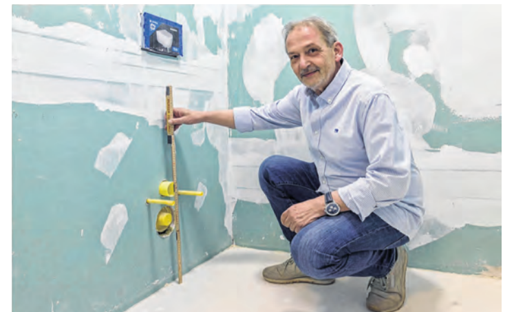
Lothar Spiegel auf der Baustelle.
