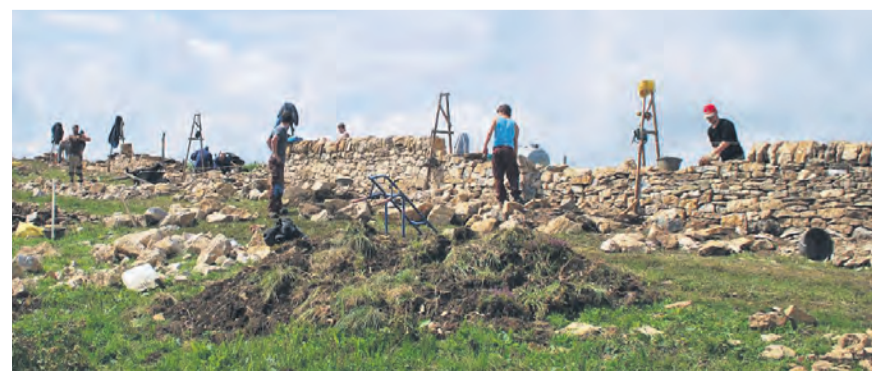
Wiederaufbau einer freistehenden, historischen und uralten Trockenmauer auf der Kantonsgrenze zwischen Solothurn und Bern. Foto: © SUS (Stiftung Umweltschutz)
