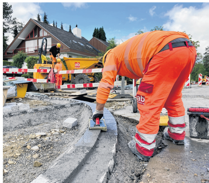
Trottoir und Randabschlüsse sind gesetzt.
