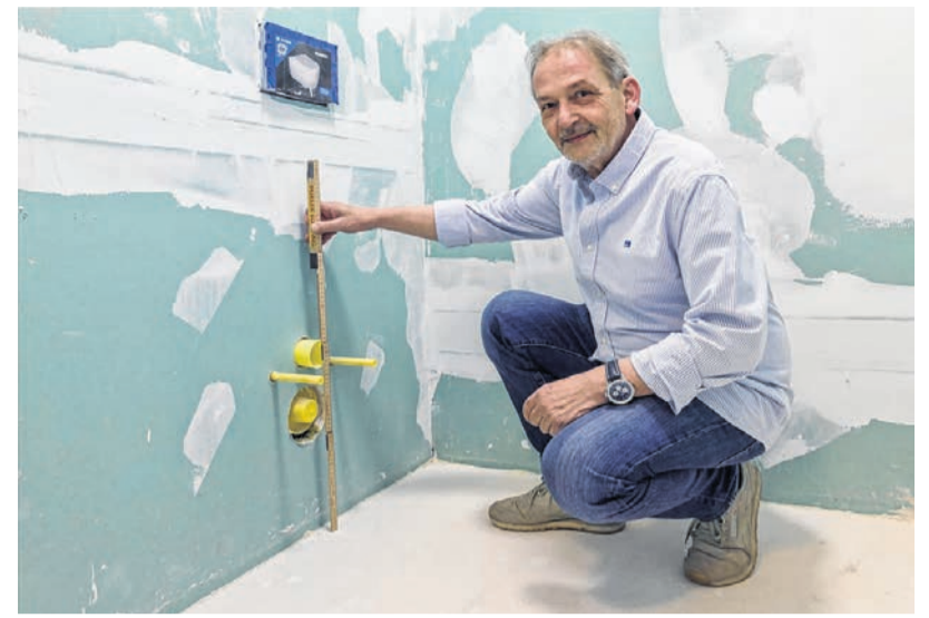
Lothar Spiegel auf der Baustelle.
