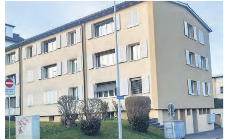
Wohnungen Neumatten Rämelsestrasse 3 + 7
