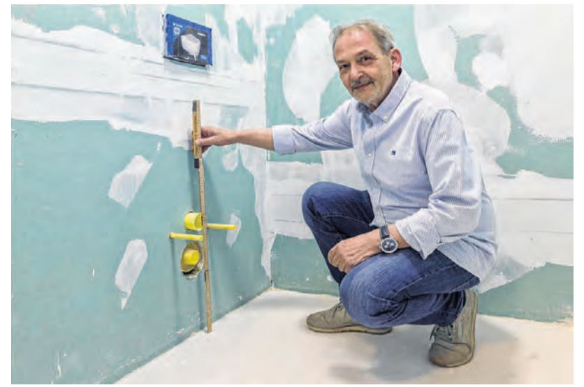
Lothar Spiegel auf der Baustelle.
