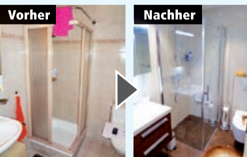
Komplettsanierung mit bodenebener Dusche
