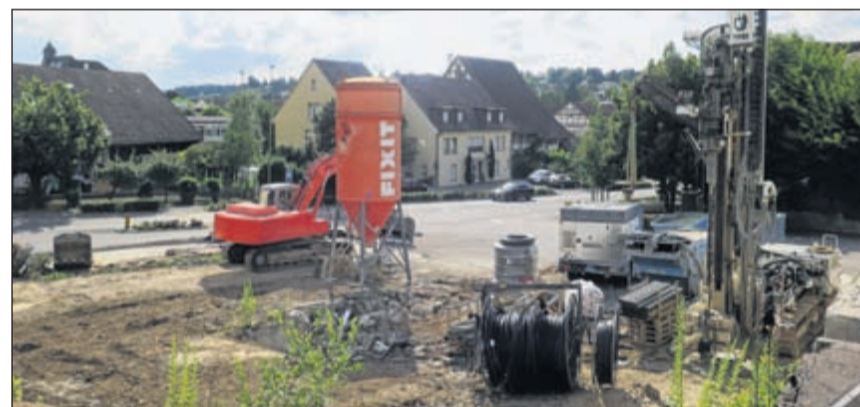
Bis vor vier Jahren stand hier die Schreinerei von Bruno Schweighauser; in den nächsten Wochen kann mit dem Bau von zwei neuen Gebäuden mit vier Wohnungen und einem «Stöckli» im Garten begonnen werden. Foto: Küng
